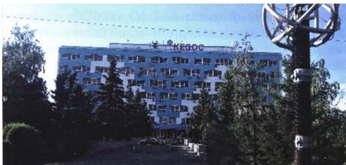
Административное здание филиала «Северные МЭС». г. Экибастуз, ул. М. Ауэзова, 126
