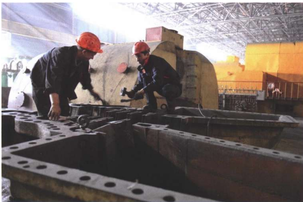
Ремонт турбины – ответственный участок.
