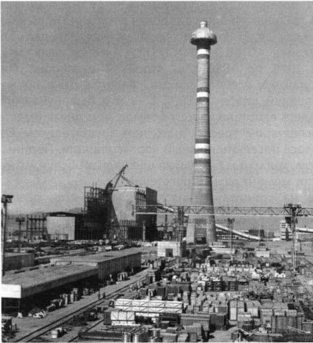
Величаво выглядит дымовая труба на фоне крупного строительства.
