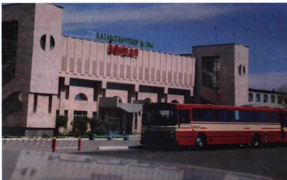
Здание Железнодорожного вокзала.
